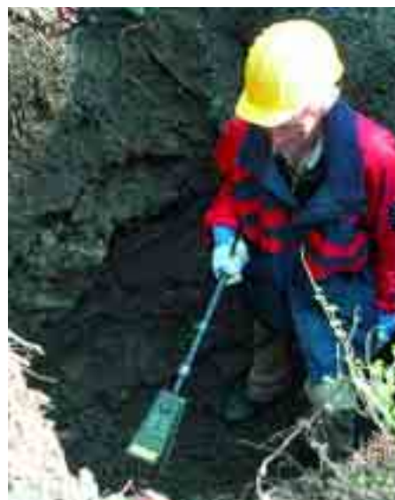
Sprengmeister Thomas Gesk (Foto links) bespricht mit einem Arbeiter die weitere Vorgehensweise bei der Bombensuche. Das im voraus gefertigte Bodenprotokoll gibt Aufschluss über mögliche Risiken beim Bohren (Foto links). Das Bohrloch hat längst Mannshöhe und ein Arbeiter prüft mit der Bodensonde den Untergrund (rechts)
